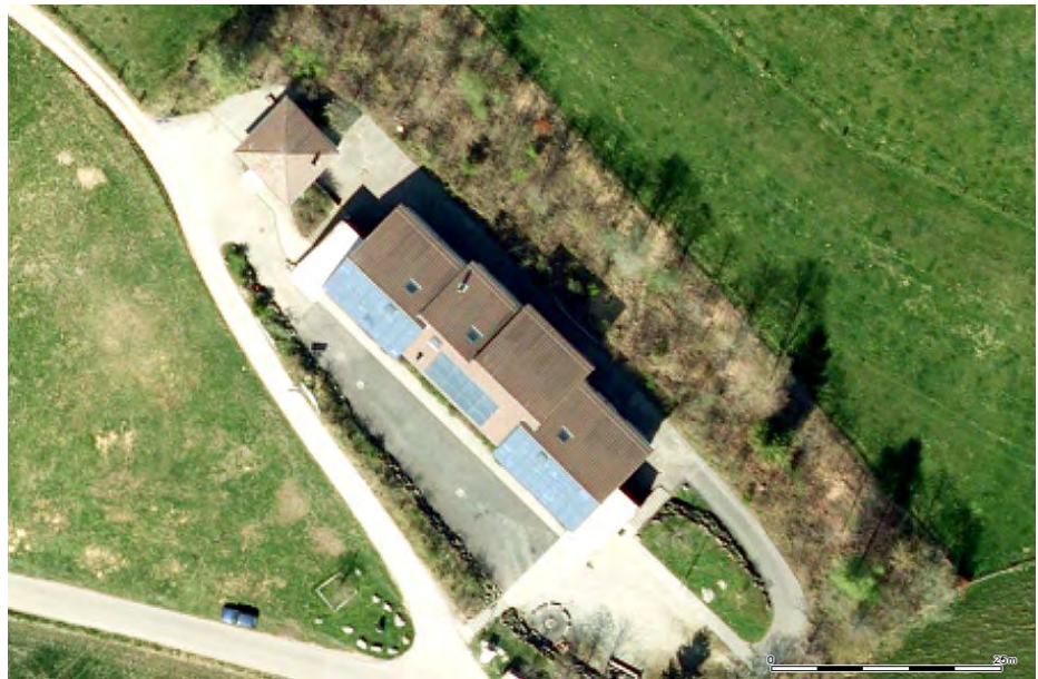
Abbildung 5: Schrägdächer geben in der Regel die Ausrichtung der Kollektoren vor. In der Abbildung sind sowohl Photovoltaikmodule wie auch solarthermische Kollektoren im Schrägdach integriert. Quelle: Geoportal Köniz
