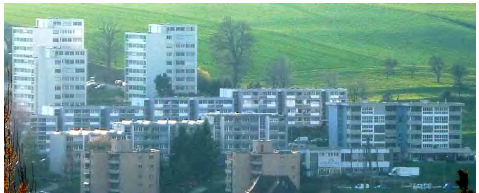
Abbildungen 15 + 16: Städtische Dachlandschaft mit Objekten mittlerer bis höherer Potenzialklasse und Solaranlagen. Photo: NET Nowak Energie & Technologie AG
