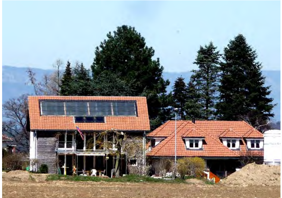
Abbildung 12: Nachbargebäude mit unterschiedlichem solarthermischem Potenzialindex. Das Gebäude der Potenzialklasse A nutzt effektiv die solarthermische Energie. Photo: NET Nowak Energie & Technologie AG
