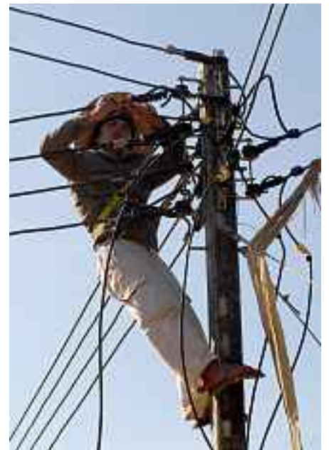
Construction du réseau d'électricité villageois
